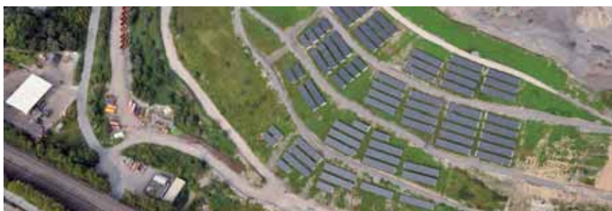
Abb.: Solaranlage des Umweltservice Bochum auf der Zentraldeponie Kornharpen | Stadt Bochum
