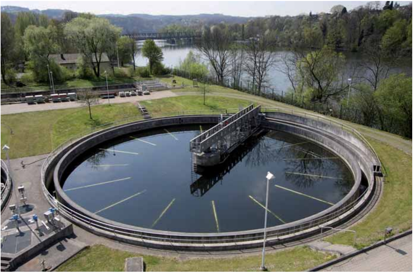
Abb.: Kläranlage Essen-Kupferdreh | Ruhrverband
