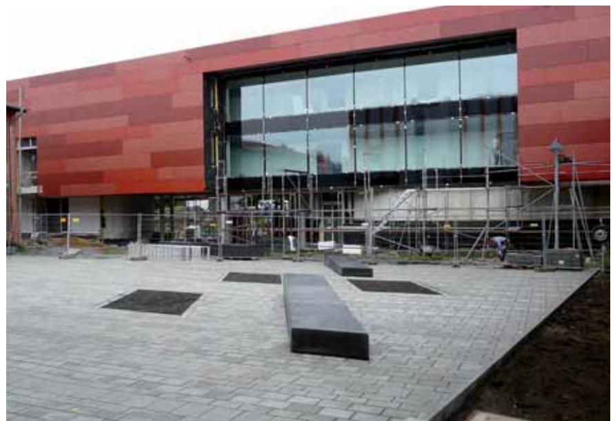
Abb.: Gymnasium Essen-Überruhr (KP II-Projekt) in Passivhausbauweise | Stadt Essen
