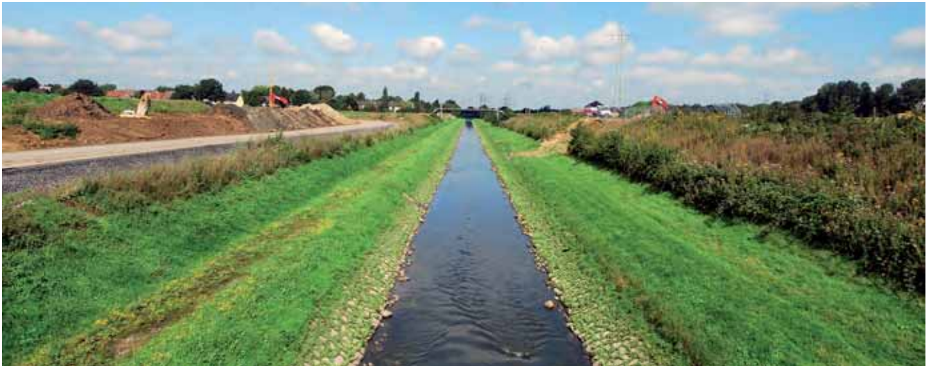
Abb.: Emscherumbau in Dortmund | EG
